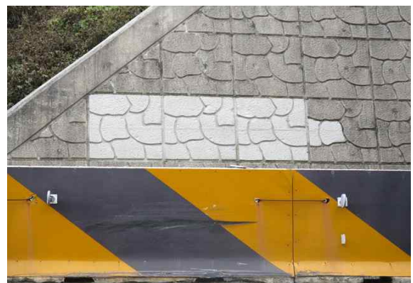
종점부 옹벽 백태 보수
