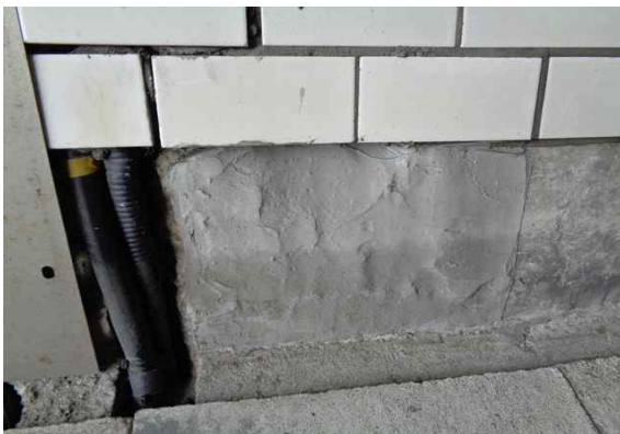
라이닝 SPAN.1 파손 보수
