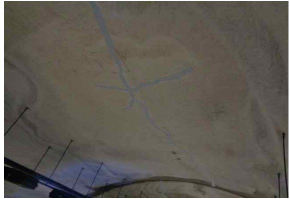
라이닝 SPAN.26 균열 보수
