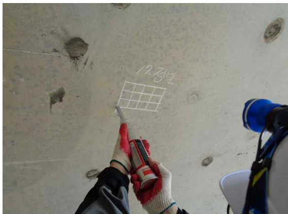
반발경도 측정 현황(천단부)
