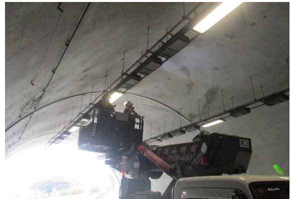
고소작업차를 이용한 외관조사 현황③
