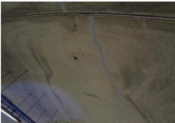
라이닝 SPAN.43 균열 보수
