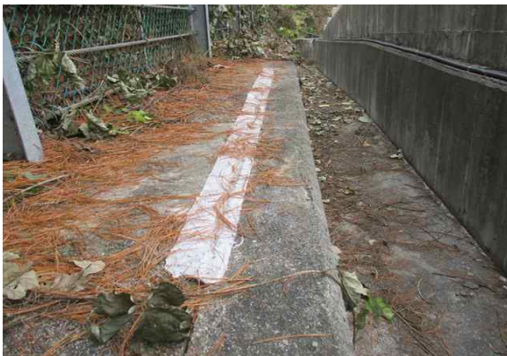
종점부 갯문 배면 이격 보수
