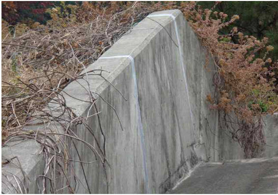
시점부 갯문 도수로 균열 보수
