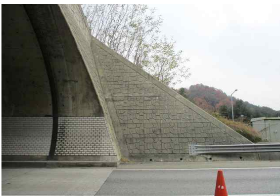
시점부 옹벽 전경
