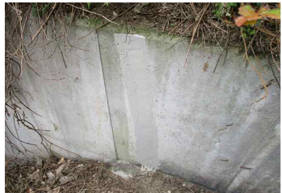
종점부 갯문 도수로 균열 보수
