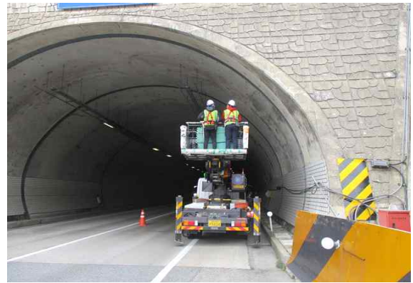
고소작업차를 이용한 외관조사 현황①
