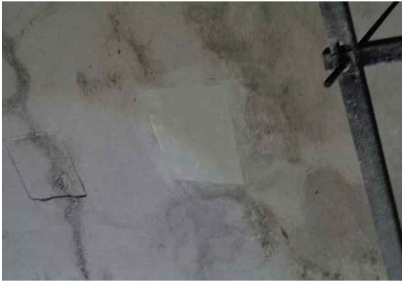
라이닝 SPAN.3 재료분리 보수
