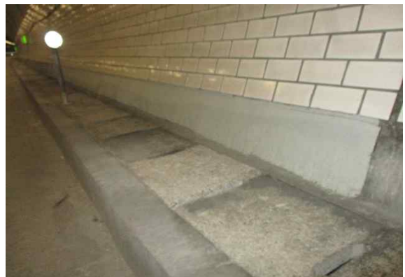
라이닝 SPAN.52 망상균열 보수
